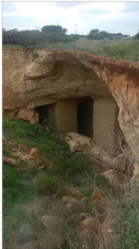
Figura 1. Sinkhole (Marsala, Trapani).
