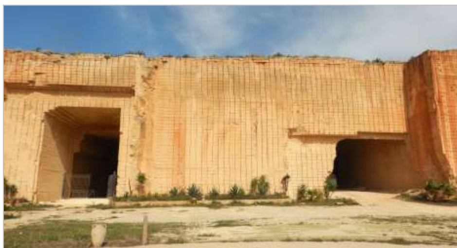
Figura 13. Ingresso Cava Foderà.
