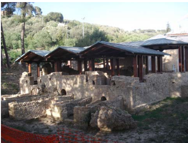
Nuove coperture in legno lamellare dell'edificio delle terme
