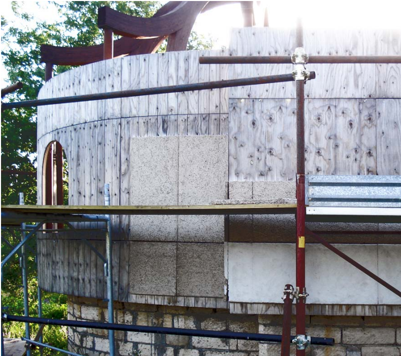
Prototipo del nuovo rivestimento costituito da pannellature in legno, eraclit, stucco
