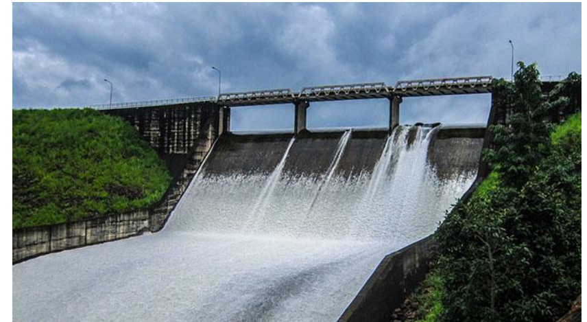
Impianti di produzione
