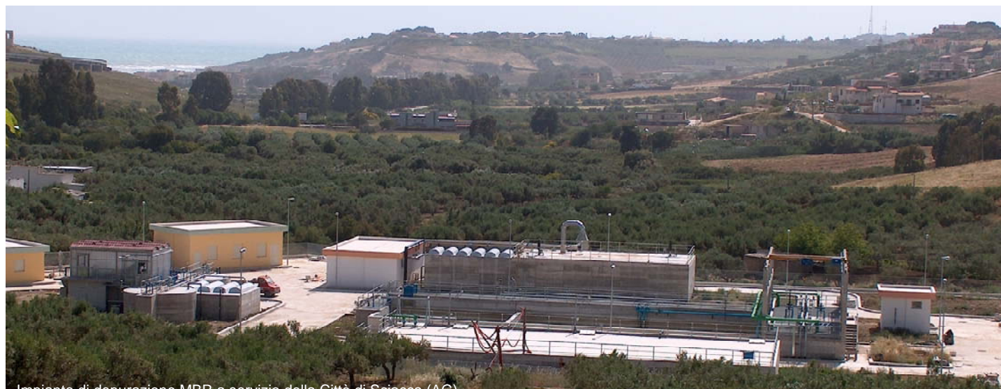
Impianto di depurazione MBR a servizio della Città di Sciacca (AG)
