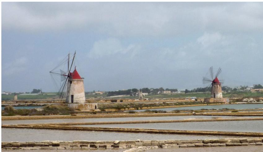
**Figura 7.3:** Le saline di Marsala (Tp); i mulini a vento sono usati per pompare l'acqua nelle differenti vasche delle saline.
