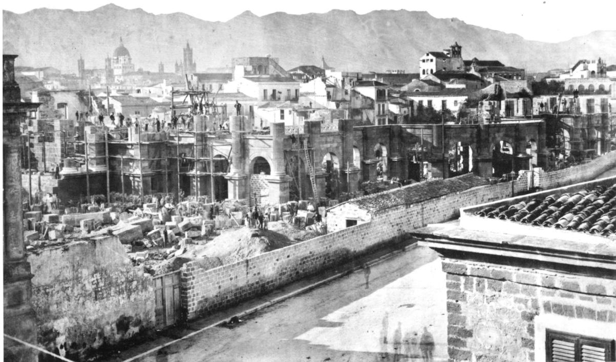
Figura 4: la foto storica documenta una fase iniziale della costruzione della muratura esterna con semicolonne<sup>38</sup>
