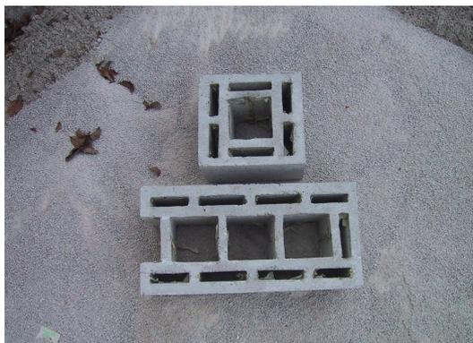
Figura 10. Blocchi di calcestruzzo leggero strutturale con inerti di pomice (Amato et al. 2011).
