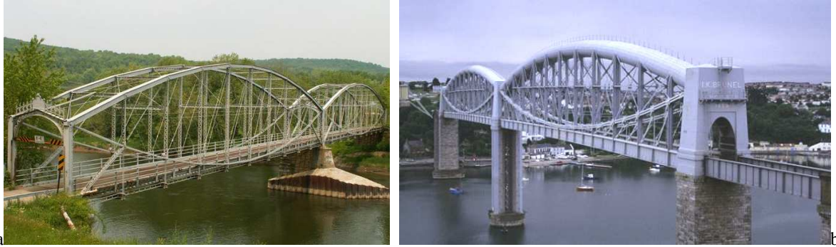
Figure 4. Lenticular bridges. a) Quaquaga bridge, USA. b) Royal Albert Bridge, UK (I. K. Brunel).
