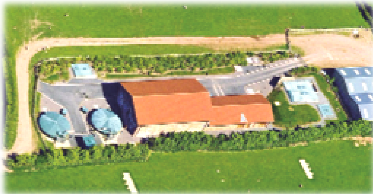
Impianto MBR Porlock - Kubota, UK
