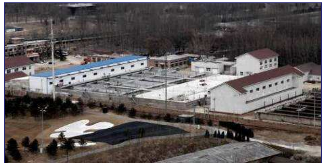
78000 m 3 /d - Villaggio Olimpico Beijing, Cina (Siemens)
