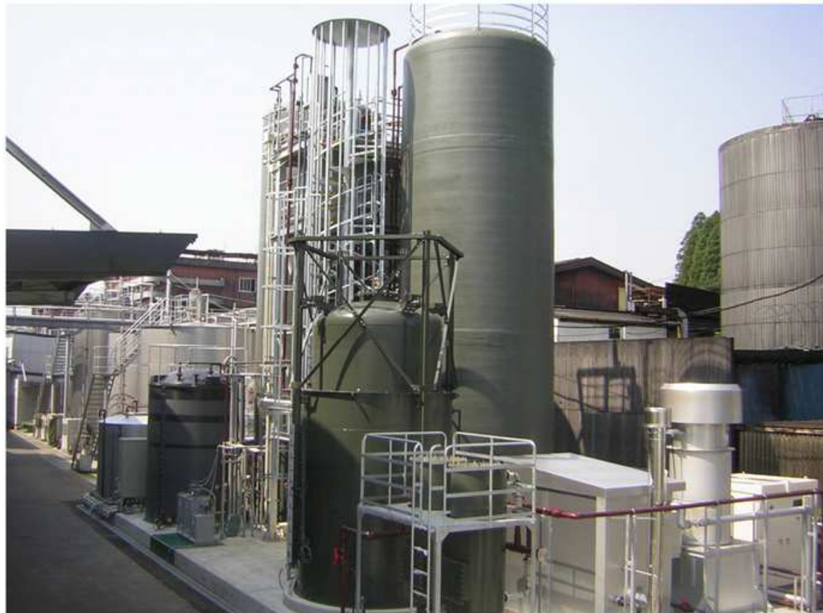
Impianto KSAMBR per il trattamento di acque reflue di distilleria - Giappone, Kubota
