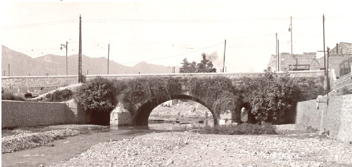
Figura 25: Foto del ponte delle Teste (lato valle) tratta dall'archivio Dante e Giuseppe Cappellani, databile ai mesi precedenti l'alluvione del 1931. La vegetazione infestante ostruiva gran parte delle campate laterali.
