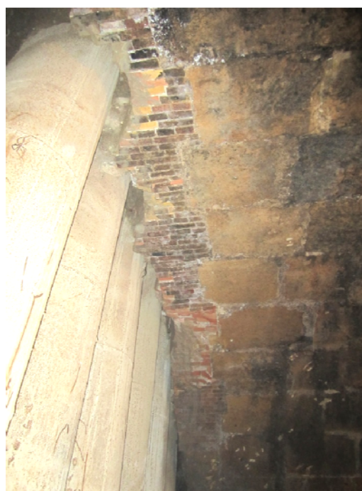
Figura 34: Il crollo parziale del parapetto mette in mostra cinque condotte d'acqua incassate al di sotto del paramento esterno.
