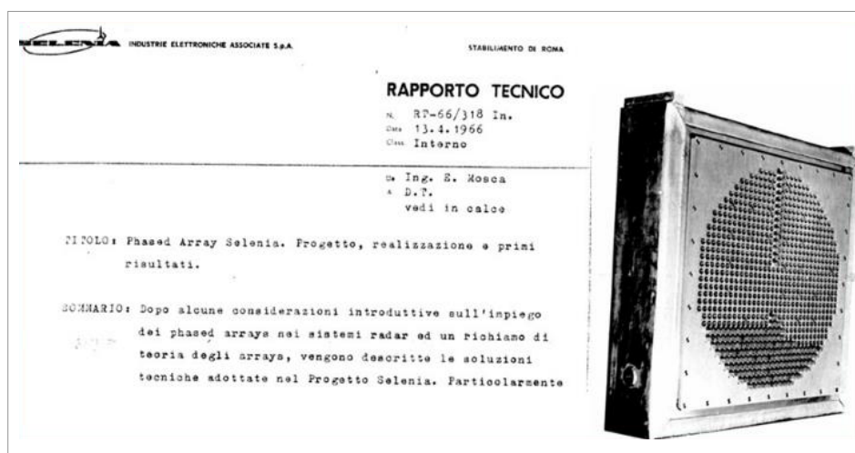
Figura 4: Il primo phased array di Selenia (1966) (slide 29).
