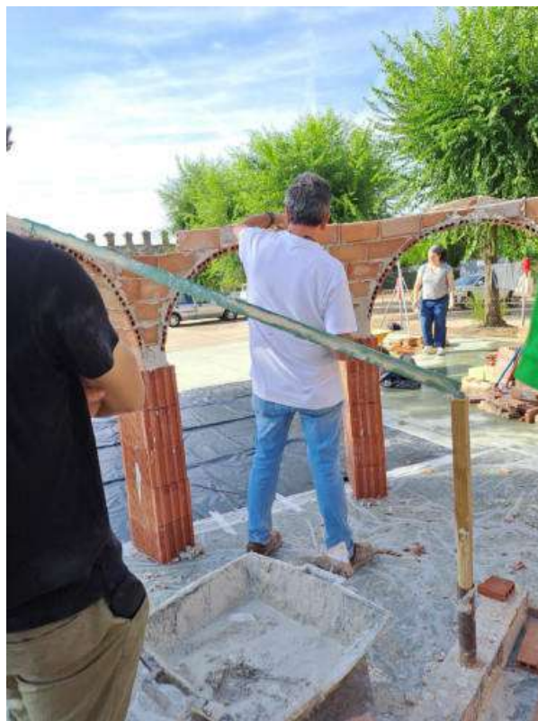
Fig. 5. In primo piano, strumento utilizzato come guida per la posa dei mattoni della cupola (foto dell'Autore).
