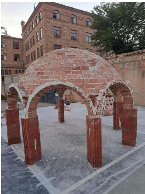
Fig. 4. Cupola in mattoni sottili e gesso ultimata (foto dell'Autore).
