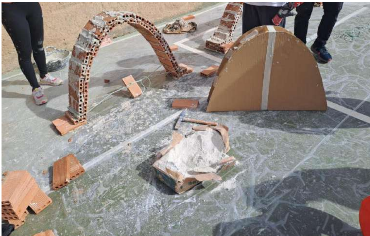
Fig. 3. Arco catenario e relativa centina in cartone (foto dell'Autore).
