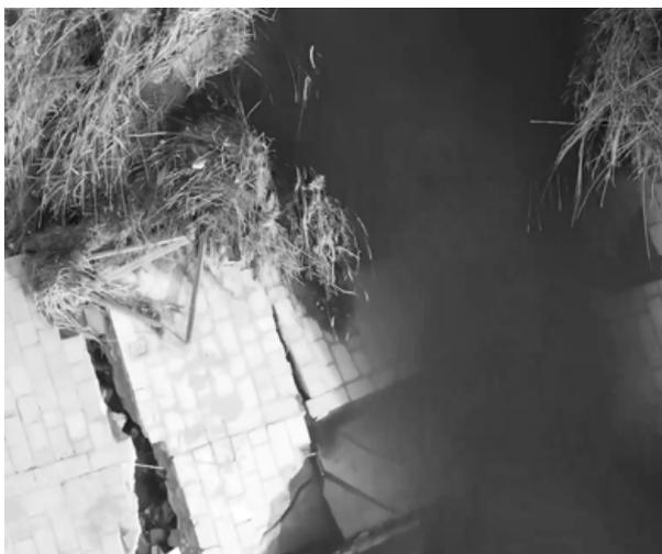
Fig. 2 Kamarina, resti del ponte sul fiume Ippari (SP102), effetti dell'alluvione di giorno 11.02.2023 (foto dell'autrice, 2023).
