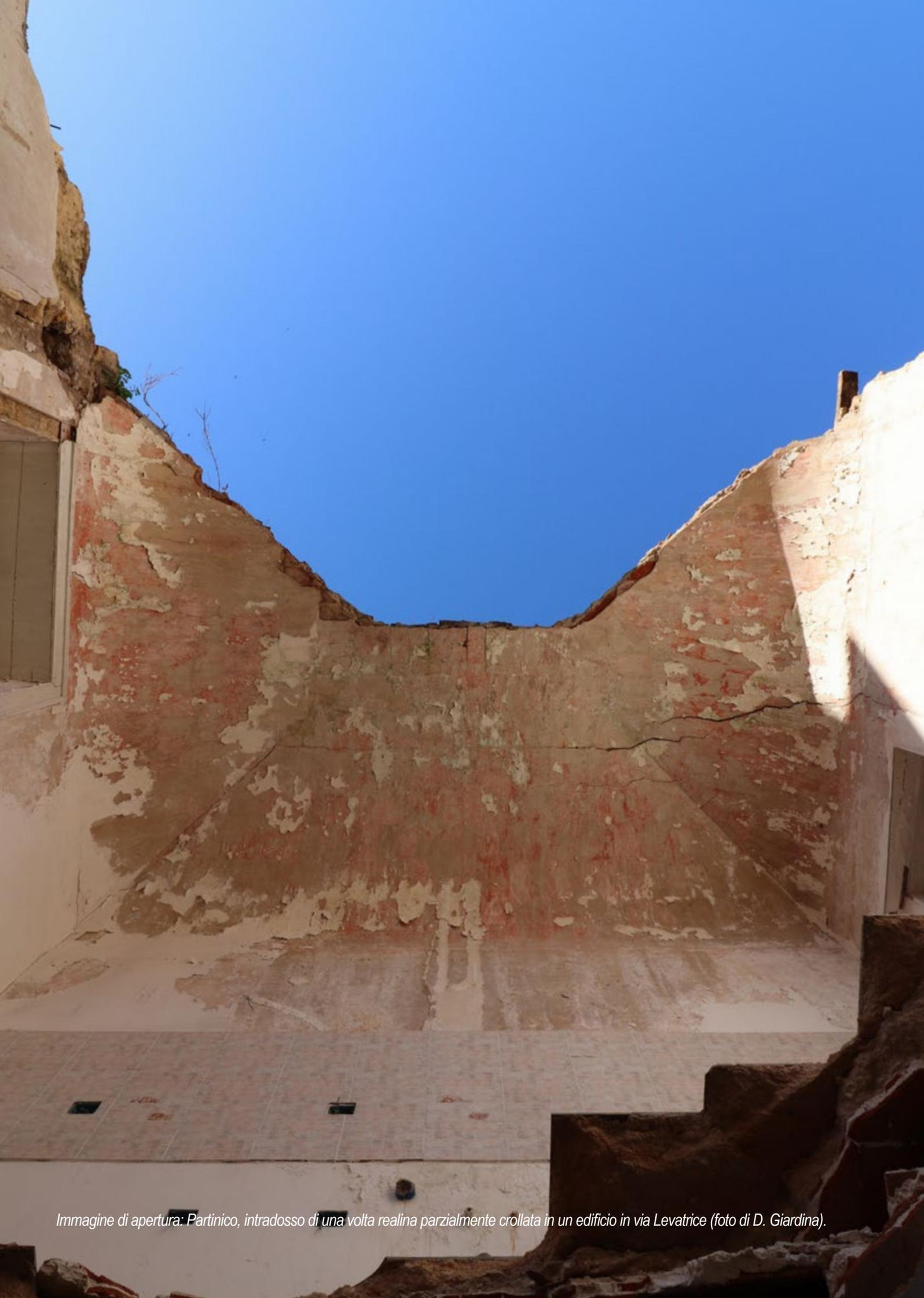
*Immagine di apertura: Partinico, intradosso di una volta realina parzialmente crollata in un edificio in via Levatrice (foto di D. Giardina).*
