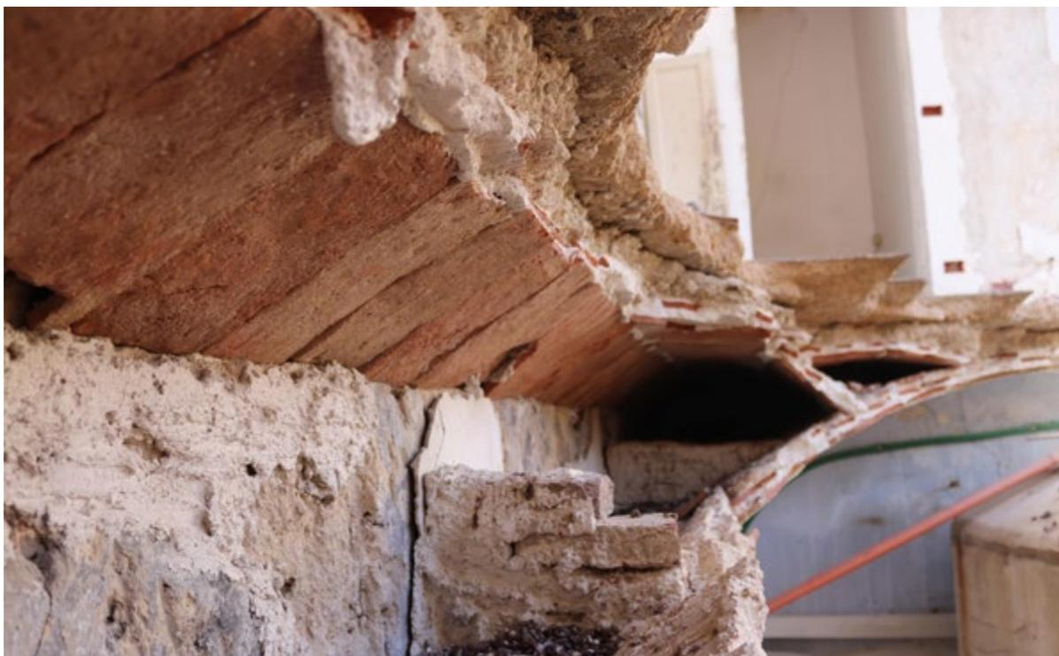
*Fig. 8. Elementi di rinforzo di una volta a botte parzialmente crollata in via Levatrice a Partinico; si riconoscono due frenelli in mattoni e gesso e, in secondo piano, la sagoma della controvoltina e della doppia controvoltina (foto di D. Giardina).*
