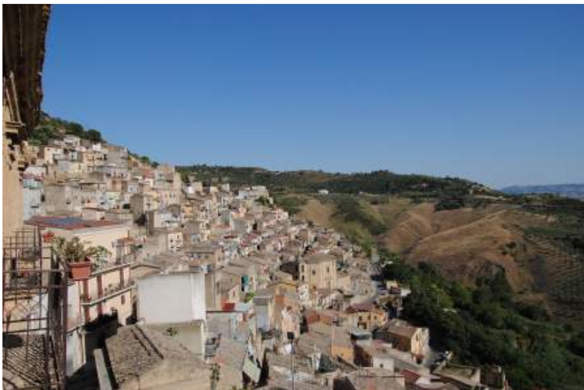
Fig. 3. Leonforte, vista del quartiere storico da Palazzo Branciforti, l'interazione tra natura e costruito connota il margine meridionale della città (foto di C. Circo).
