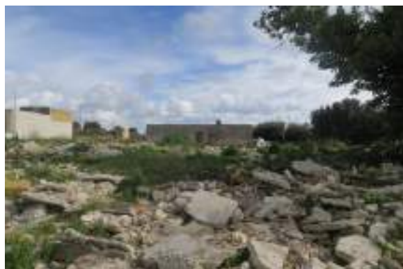
Fig. 8. Campobello di Mazara, macerie a contrada Erbe Bianche due anni dopo la demolizione della baraccopoli, 2019 (foto dell'autore).
