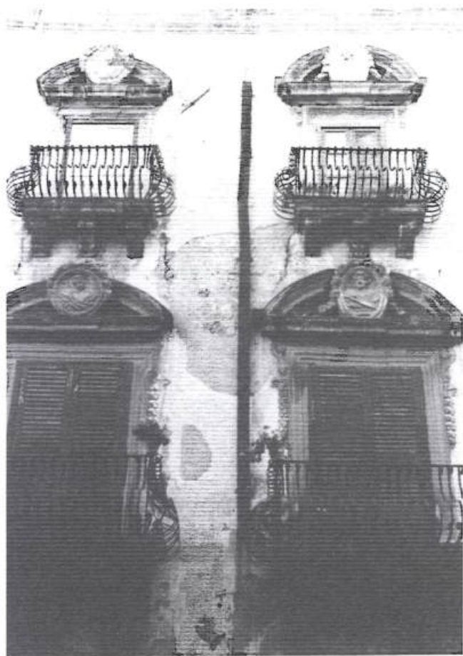
Palazzo Lungarini. Tracce di intonaco sgraffiato.
