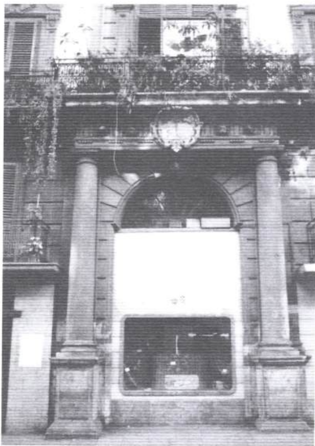
Palazzo Isnello. Ingresso impropriamente convertito in negozio.
