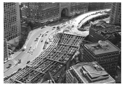
A sinistra plastico del Boston's artery-tunnel; a destra i lavori di costruzione del tunnel che ha permesso di fare passare sotto la città 5,6 Km della principale autostrada cittadina.
