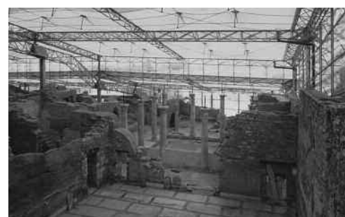
Interno di una nuova copertura in traslucido a Efeso, Turchia.
