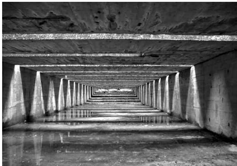
Tetto della base sottomarina con struttura in blocchi di cemento armato tipo Frangost.
