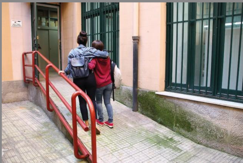
Rampa accesso edificio
