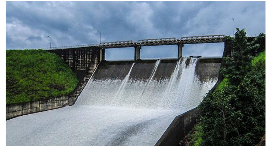
Impianti di produzione
