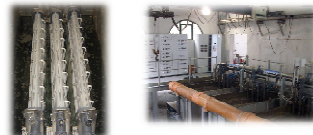
Impianto di depurazione «Occhio Marino» di Capri
