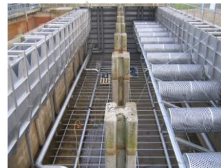
Oxford WWTP, UK
