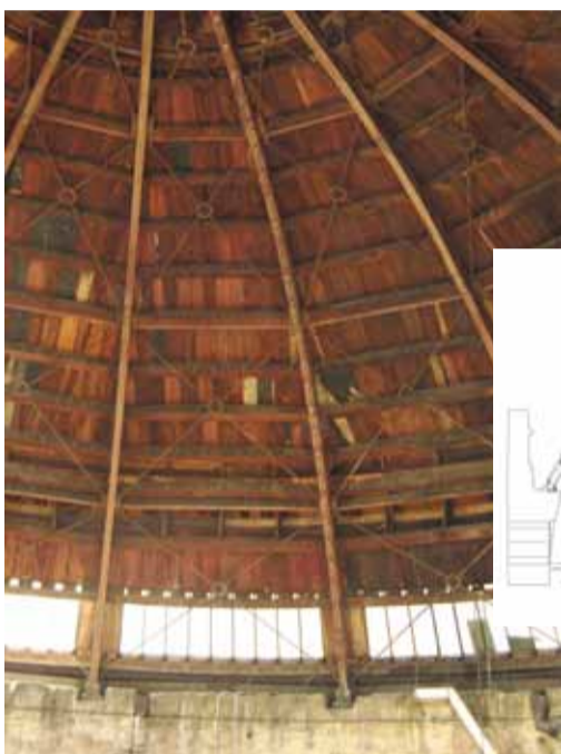
Prove dinamiche sulla cupola del Teatro Massimo di Palermo per la verifica di stabilità della struttura a carichi impulsivi
